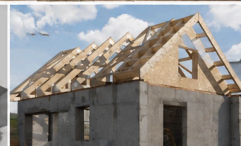
SUHA GRADNJA BEZ ARMATURE
